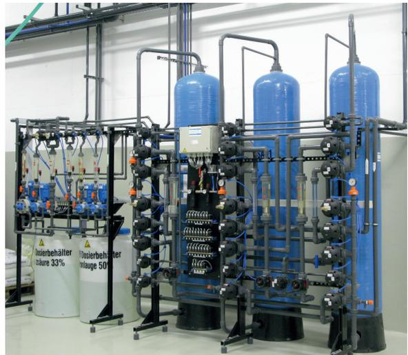
Abb. 4 und 5: Verdampfer K7000 sowie Ionenaustauscher für die Aufkonzentrierung von Nickel
